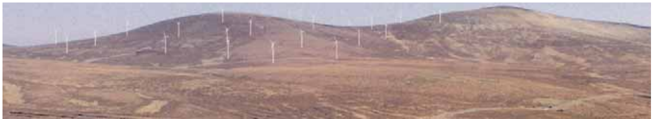
1(b) Forbairt fhuinnimh ghaoithe agus go leor tuirbíní ar mheánairde i gceist leis – féadfaidh seo a bheith mí-feiliúnach. Is féidir fairsinge spásúil forbartha fuinnimh ghaoithe a laghdú ach úsáid a bhaint as tuirbíní níos airde. Féadfaidh sin a bheith ina réiteach gurbh fhearr leis na húdaráis srl. i roinnt cás.
